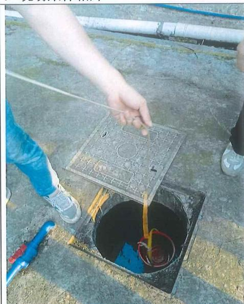
图 9.1 实验室废水处理前集水池 ★W1
